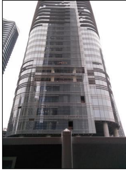
项目南面 其他办公楼
