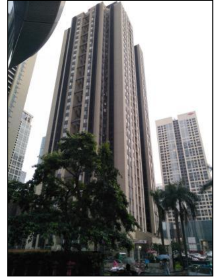
项目东面 其他办公楼
