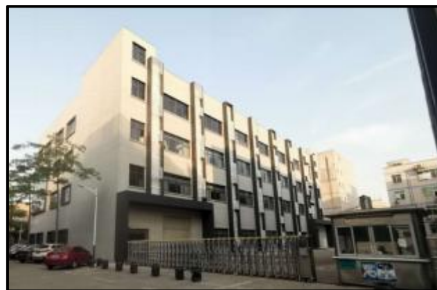
项目所在建筑主体
