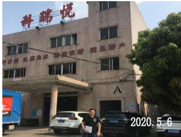
项目宿舍楼—后 1 栋所在建筑
