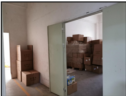
项目内部现状一
