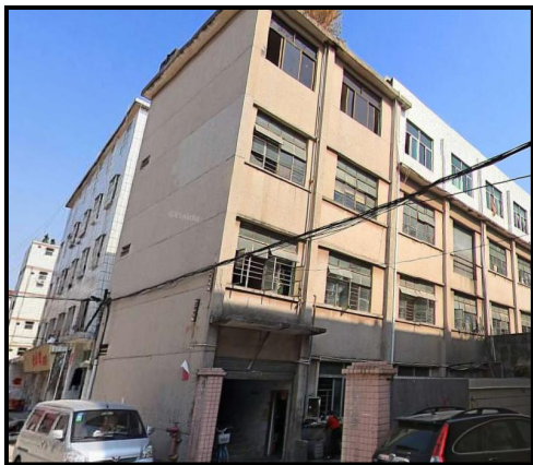
项目北面 宏盛制衣厂
