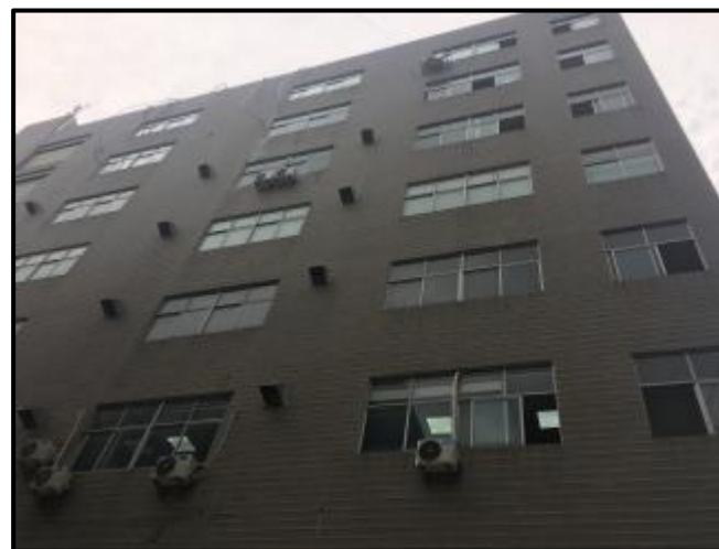
项目所在建筑楼
