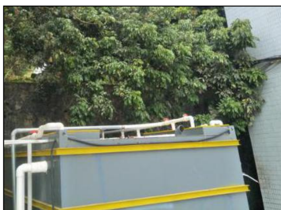
图 4-2 已建废气收集设施
