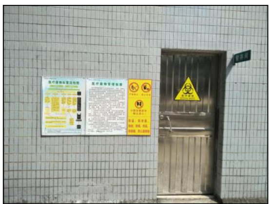
图 4-4 医疗垃圾暂存间
