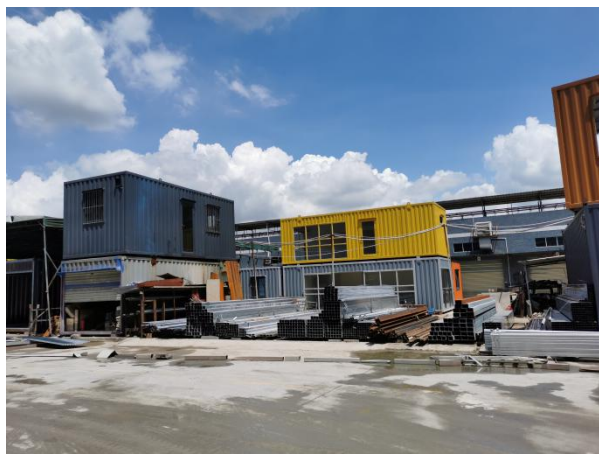
项目北面为集装箱区
