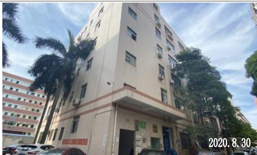
本项目所在建筑
