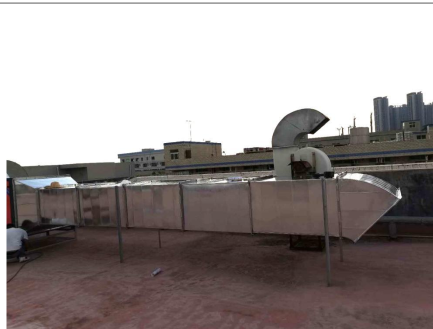
废气处理设施与废气收集排放口
