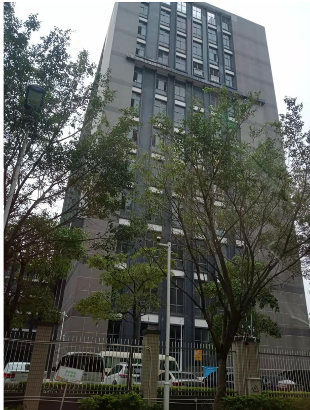
项目西面（宝龙工业园内其他企业工业厂房）
