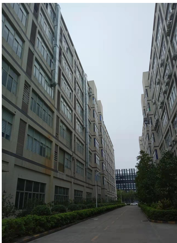
项目南面（园内其他企业工业厂房）
