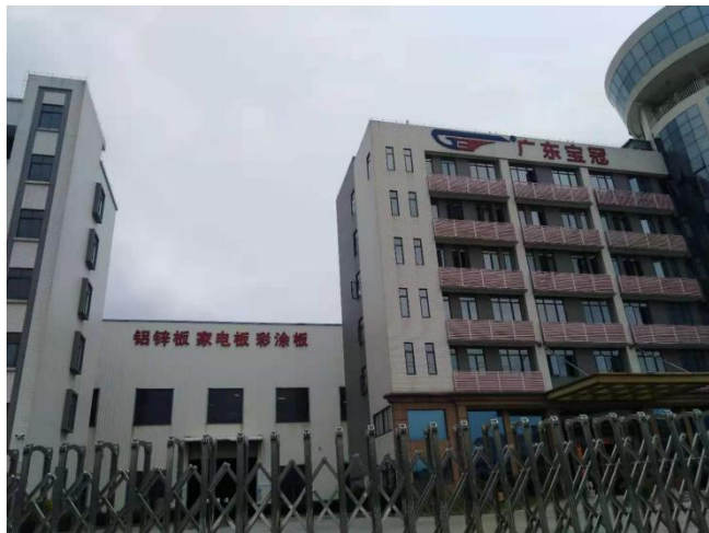
项目东面—广东宝冠板材料科技有限公司
