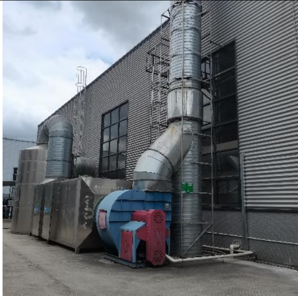
“水喷淋+UV 光解+活性炭吸附”装置处理（排油补灰、调漆、喷漆、烘干/固化有机废气）
